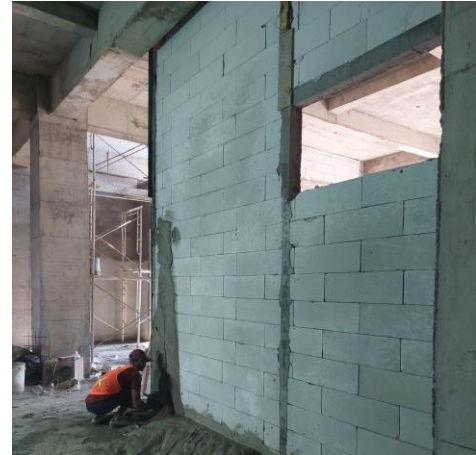
Gambar 3. Pengerjaan Plesteran Dinding Dengan Lubang Jendela
