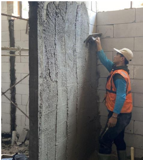
Gambar 2. Pengerjaan Plesteran Dinding Tanpa Lubang Jendela
