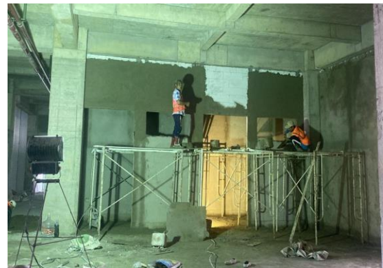
Gambar 4. Pengerjaan Plesteran Dinding Line 4-6/E
